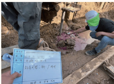
S.B.E.G 주입 후 천공슬라임 착색시험
